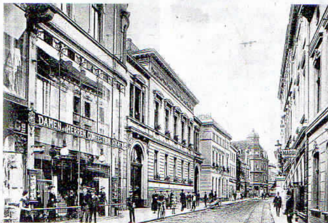
Die Viersener Hauptstraße mit dem jüdischen Kaufhaus Katzenstein.
